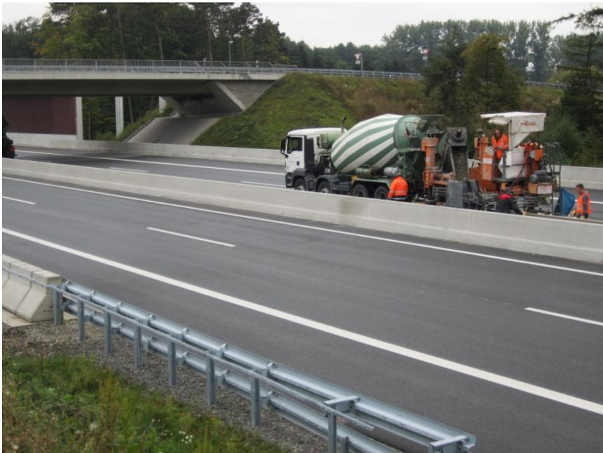
**Einbau der Ortbetonschutzwand mit Gleitschalungsfertiger**
